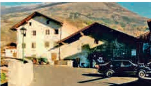
Der alte Gebäudesockel hat seine verputzte Lochfassade behalten, der neue übergreifende Baukörper wurde mit Holz verschalt: Alt und Neu sind auf den ersten Blick erkennbar und bilden eine neue architektonische Einheit.
